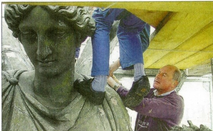
Keine Scheu vor komplizierten Aufgaben: Konrad Blamberger Senior bei Ausbesserungsarbeiten am Engel auf dem Dach des Maximilianeums.
