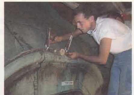
Arbeit am Dach des Müller'schen Volksbad
